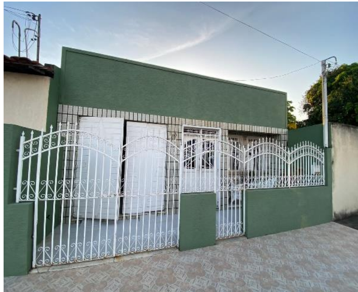
Figura 2: Residência situada na rua Elvira de Oliveira, em Lagarto/SE
