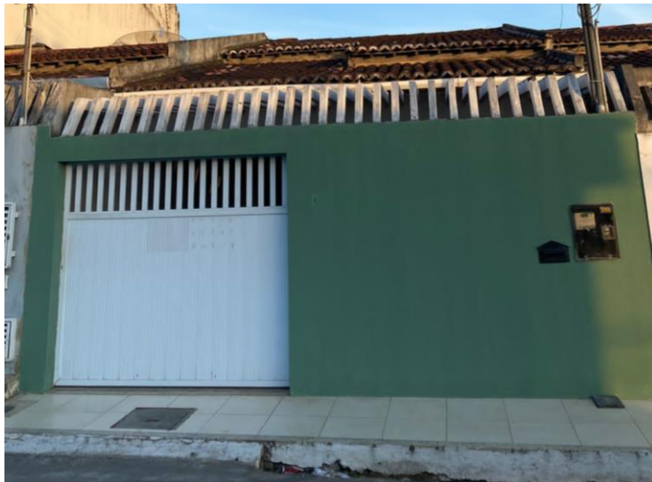
Figura 4: Residência situada na rua Elvira de Oliveira, em Lagarto/SE
