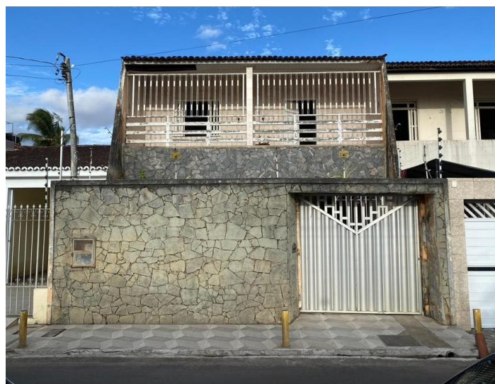
Figura 3: Residência situada na rua Elvira de Oliveira, em Lagarto/SE
