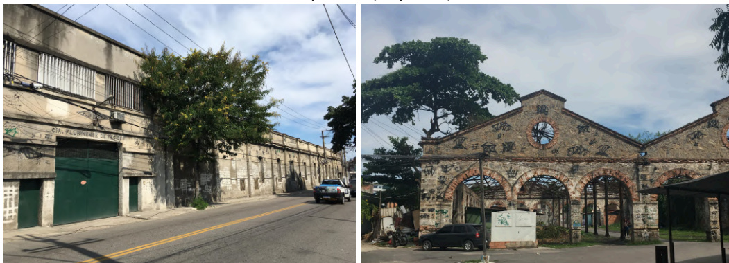
Figura 6 e 7: Fachada da antiga Cia. Fluminense de Tecidos (direita) e da antiga Oficina de Trens da Leopoldina (esquerda)
