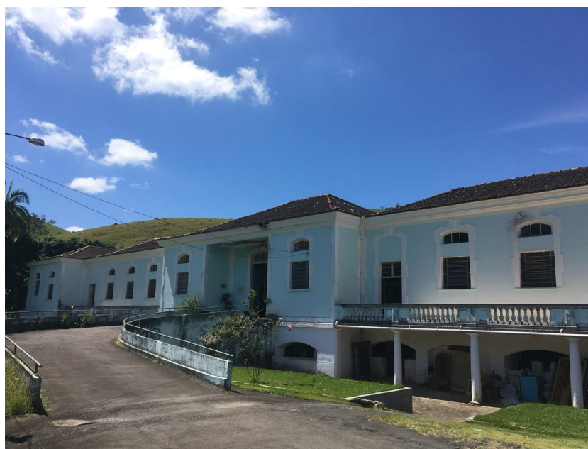
Figura 01 – ILPI Abrigo Santa Helena – Edifício administrativo.
