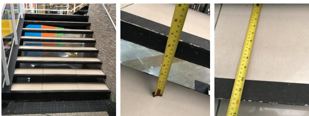
Figuras 07, 08 e 09 – Escada e dimensões dos degraus
