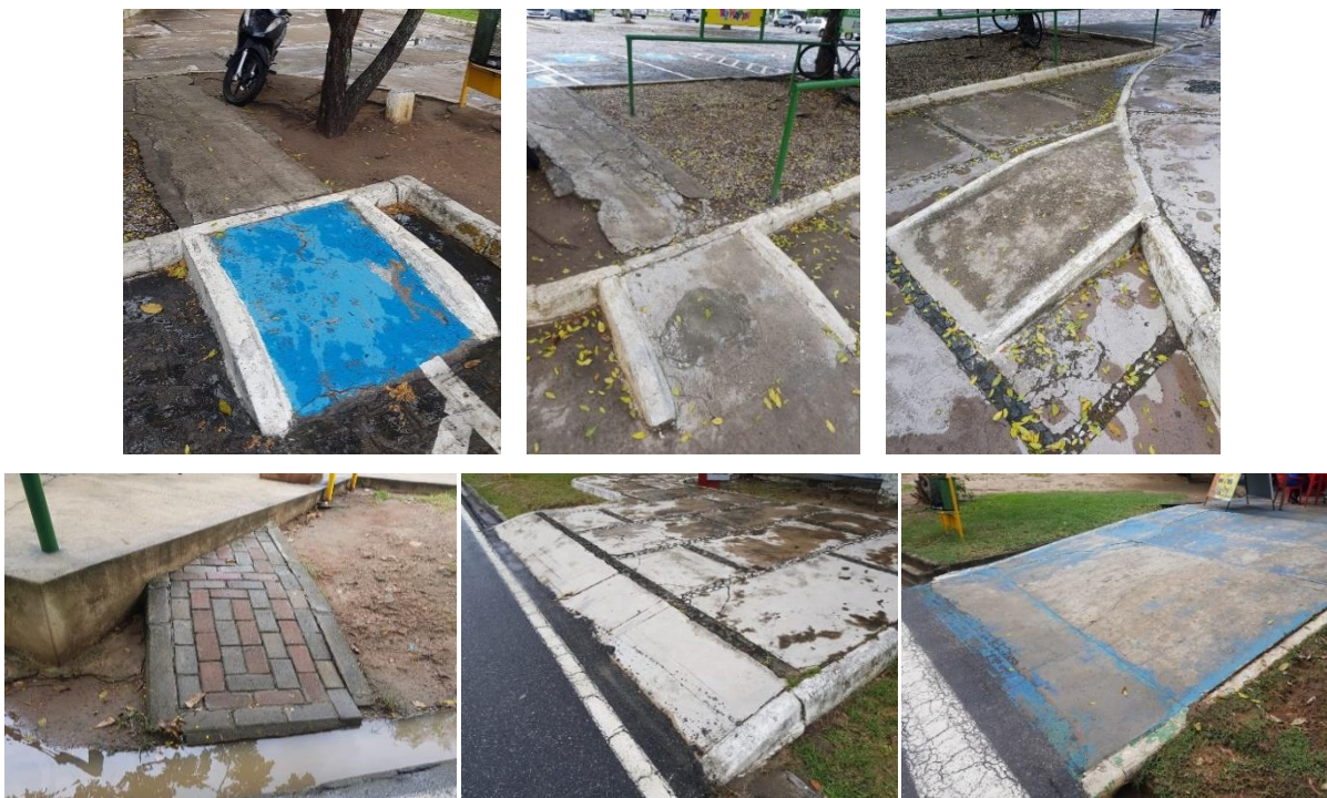
Figuras 17, 18, 19, 20, 21 e 22 – Rampas analisadas no Empreendimento Público
