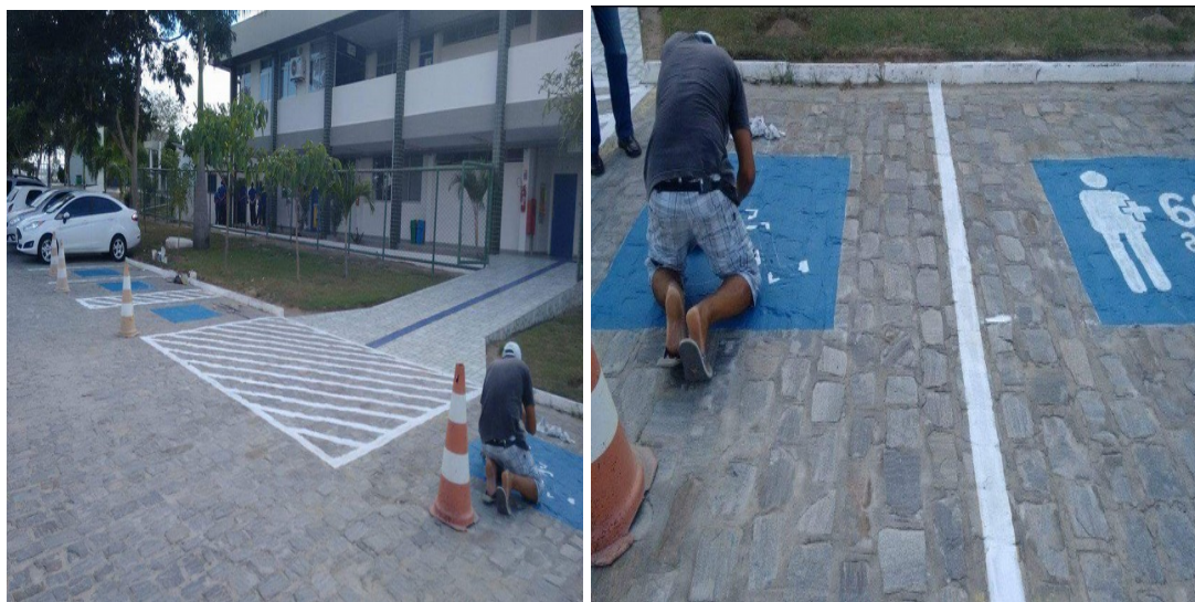
Figura 2. Processo executivo de pintura do estacionamento. IFPB, 2016.
