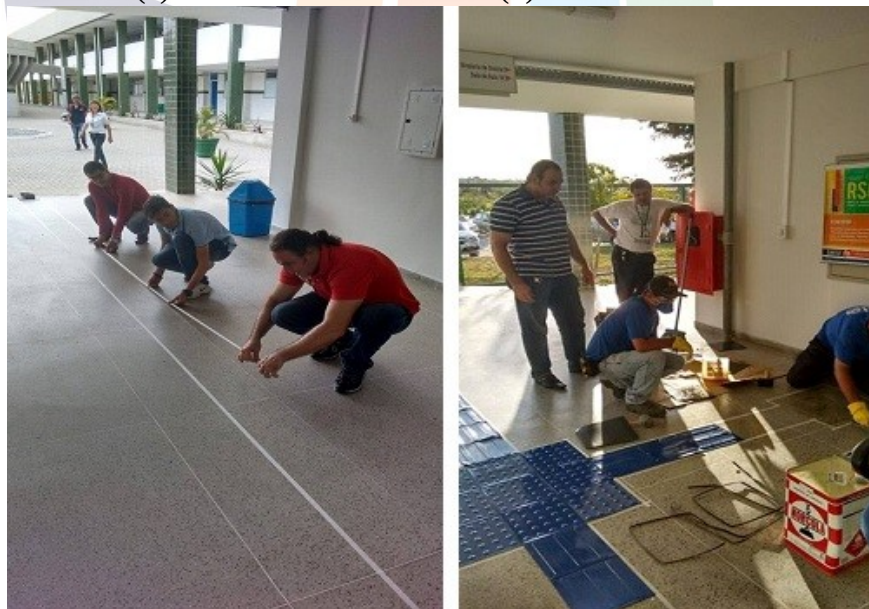
Figura 3. Processo de assentamento dos pisos táteis - Setor Administrativo. IFPB, 2016.
