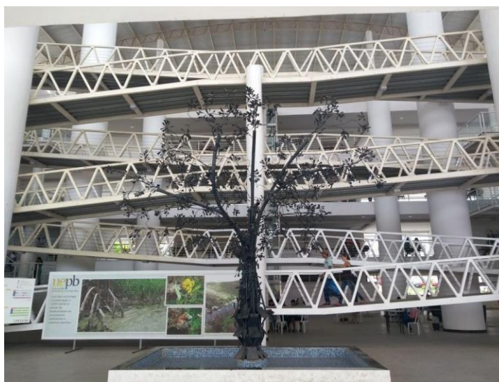
Figura 1 - Rampas de acesso aos quatro andares do bloco CIAC
