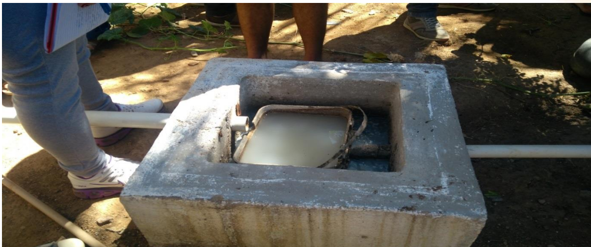
Figura3: Filtro de reutilização de água para irrigação. Acervo Pessoal.
