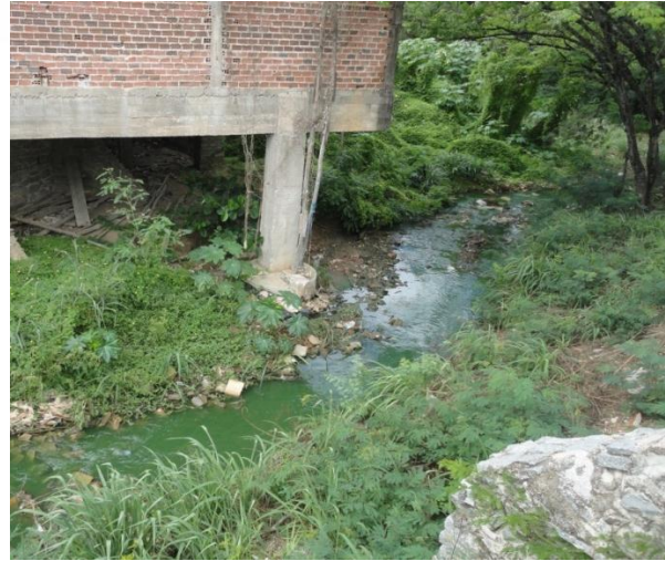
Figura 10 – Construção de uma residência no córrego que deságua no rio.
