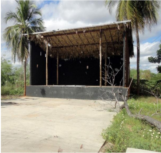
Figura 9 – Construção de um palco próximo ao rio.
