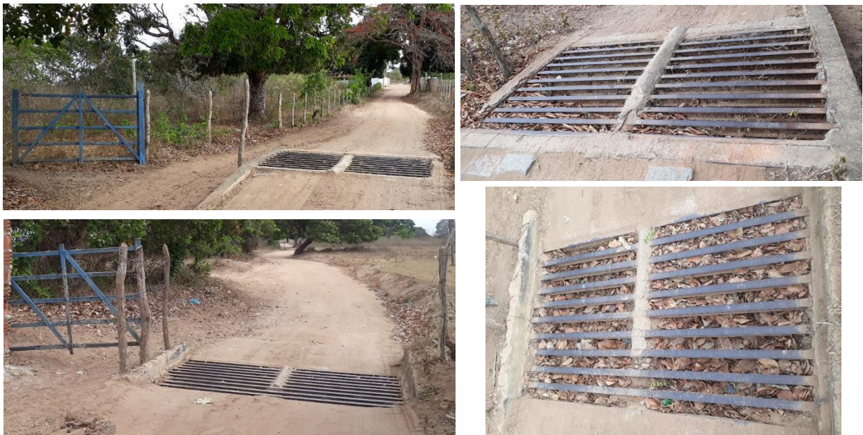
Figura 4: Os mata-burros de metal. Fonte: Autores (2018).
