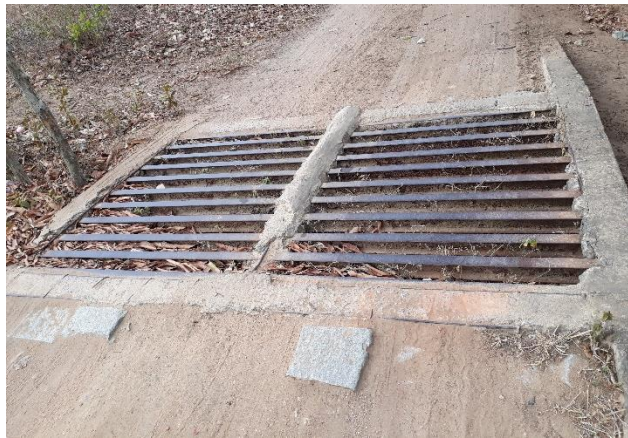
Figura 6: Mata-burros de metal em nível superior ao da rodovia. Fonte: Autores (2018).
