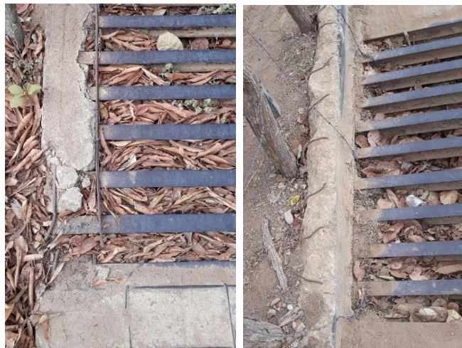
Figura 5: Defeitos nos mata-burros de metal. Fonte: Autores (2018).
