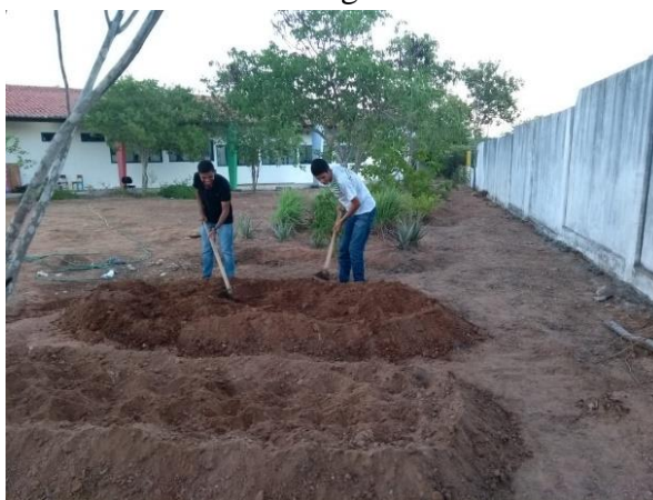
FIGURA 2. Montagem dos canteiros.
