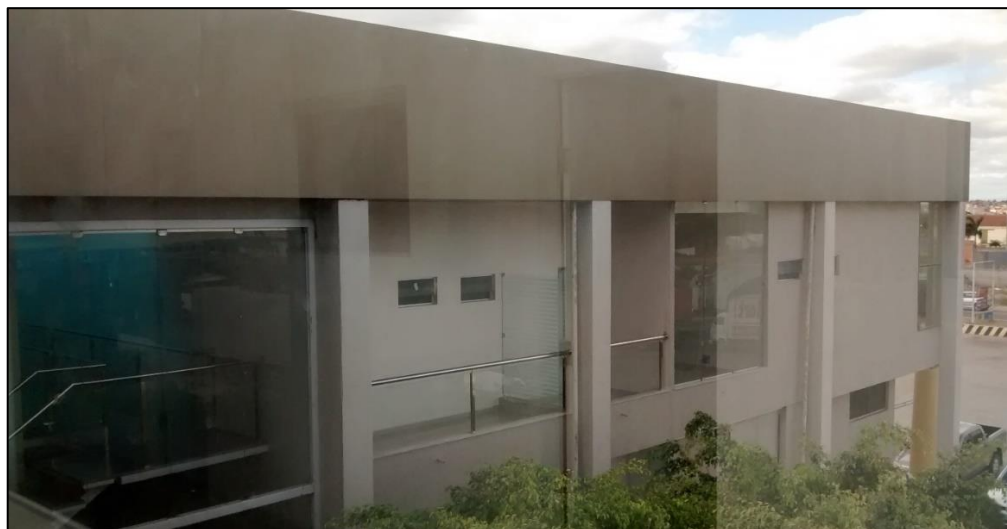
Figura 6 – Fachada lateral do prédio principal do hotel com platibanda revestida em ACM na cor champagne.
