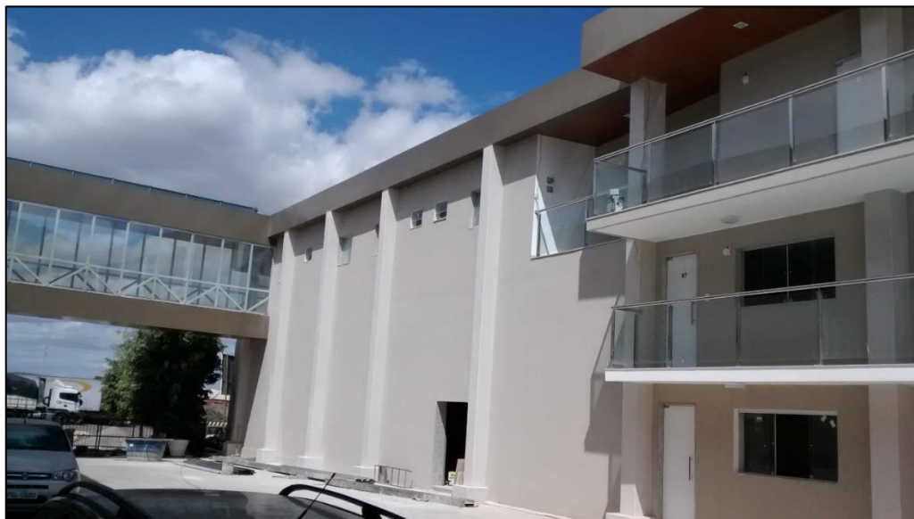
Figura 7 – Fachada lateral do 2º prédio com os pilares para reforço sacados da alvenaria.
