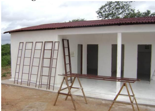
Figura 2 – Fase de acabamento
