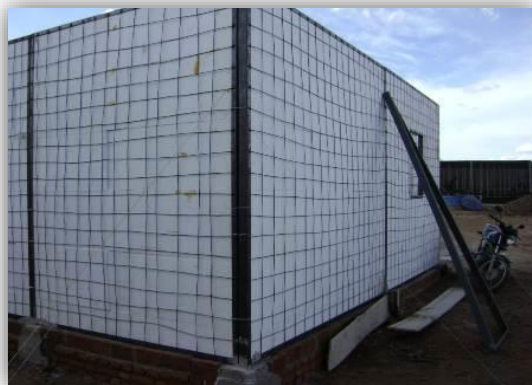
Figura 1 – Montagem das paredes
