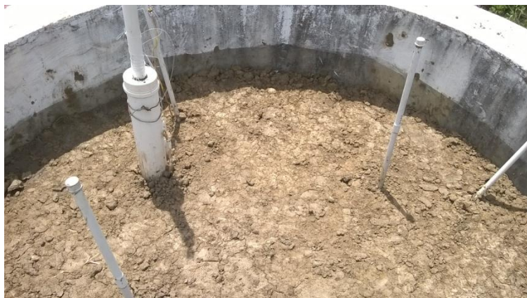
Figura 5 – Camada de cobertura após execução.
