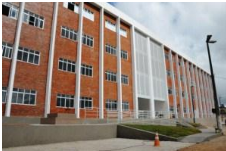
Figura 2- Fachada da edificação em análise
