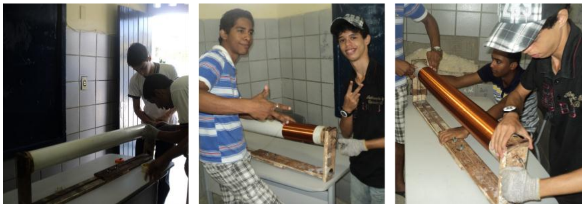
Figura 6. Construção do indutor secundário da bobina de Tesla.
