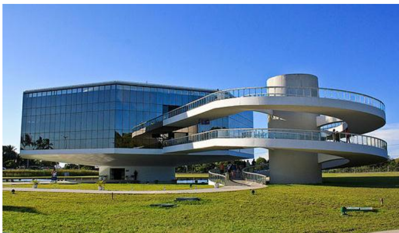
Figura 1: Estação Cabo Branco - Ciência, Cultura e Artes, em João Pessoa – PB.
