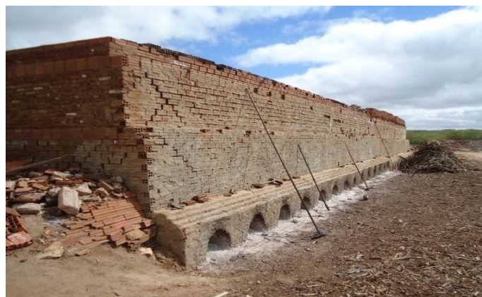
Figura 3: Modelo de forno usado por olarias no Estado da Paraíba. Fonte: Própria, 2014.
