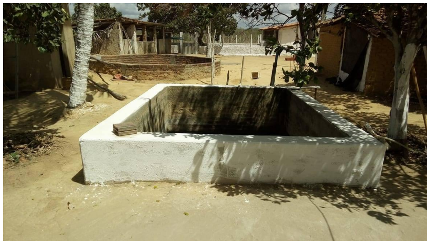
Figura 4: Tanque onde é diluído o biofertilizante líquido e bombeado para as plantas.
