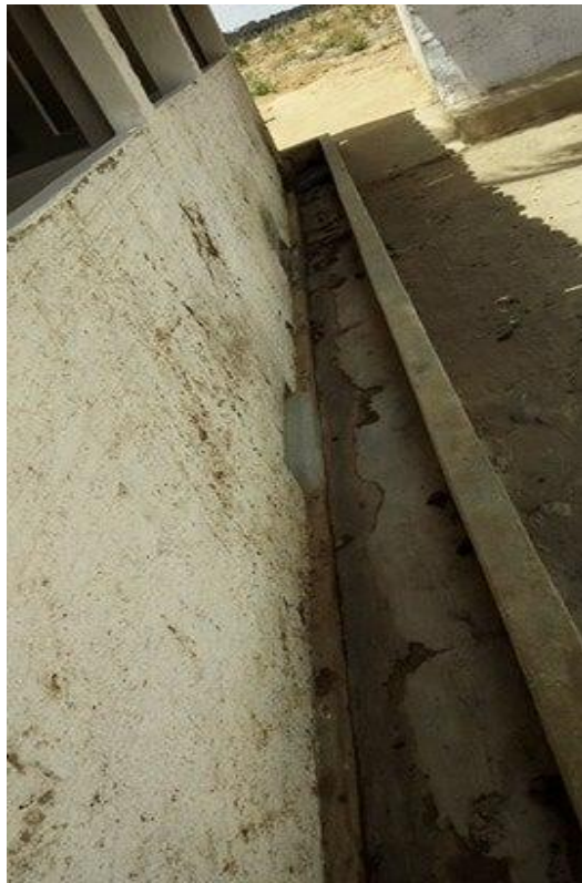
Figura 2: Calha onde os dejetos são captados.
