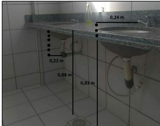
Figura 14 – Lavatórios dos banheiros. Fonte: Dados da pesquisa, 2018.
