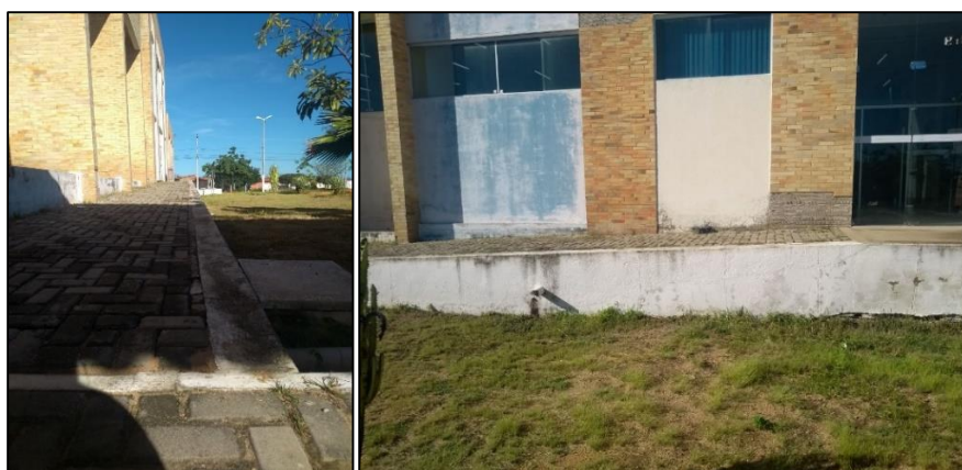
Figura 2 – Rampa de acesso à biblioteca. Fonte: Dados da pesquisa, 2018.
