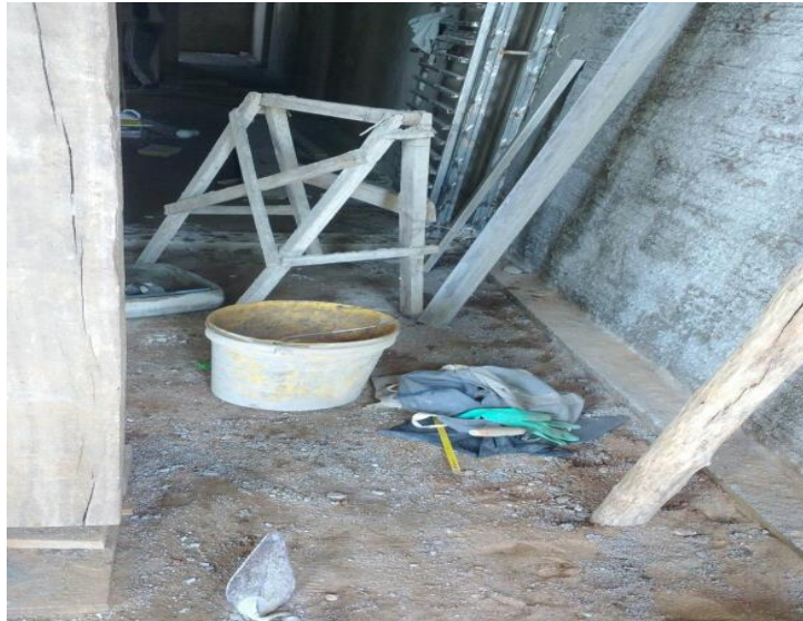
Figura 05 - Disposição dos materiais e organização na obra Fonte: Autoria Própria
