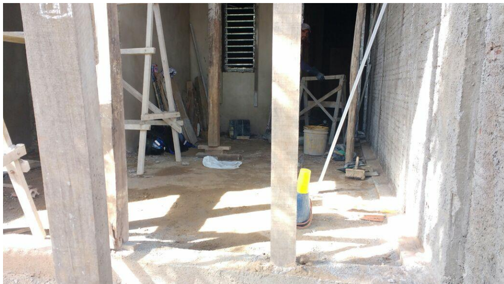
Figura 04 – Disposição dos materiais e organização na obra Fonte: Autoria Própria
