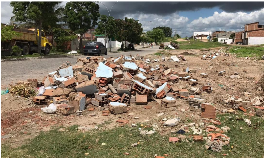
Figura 3 – Descarte irregular de RCC
