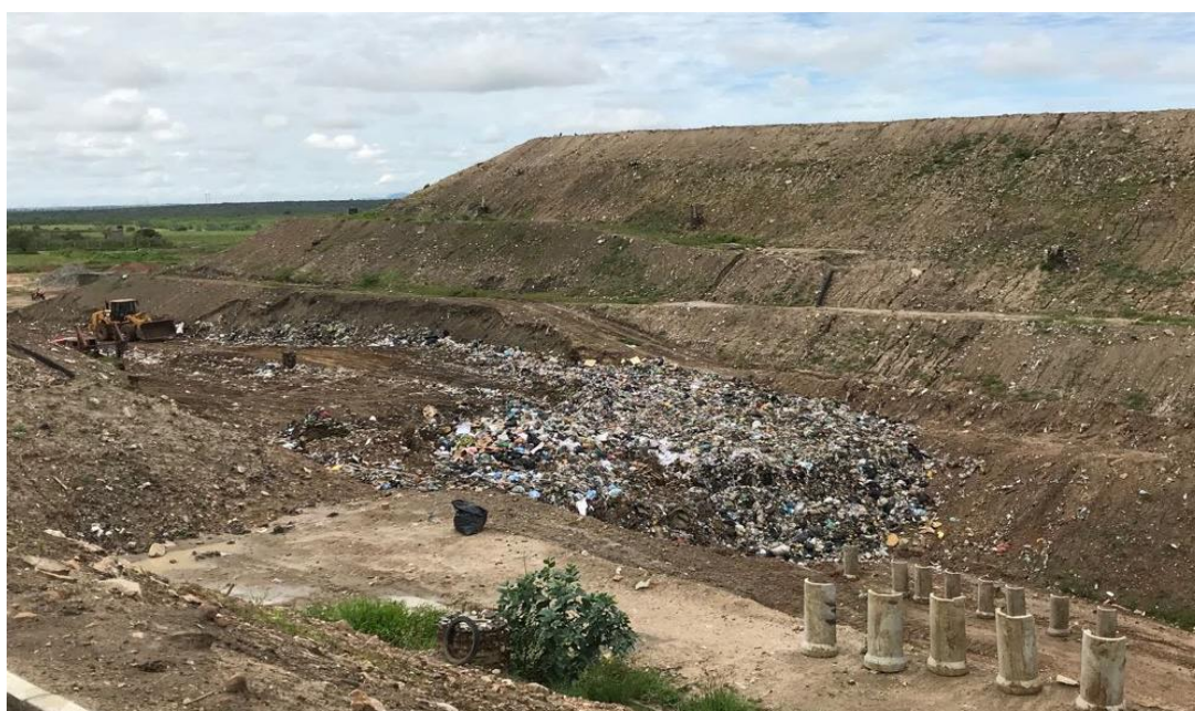
Figura 2 – Aterro Sanitário de Campina Grande-PB
