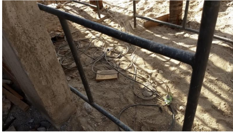
Figura 3: Extensões utilizadas dentro da obra.
