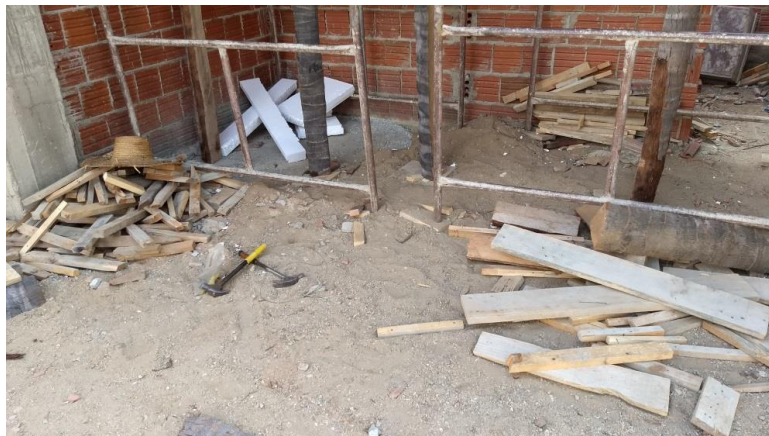
Figura 2: Andaimes apoiados em ripas.
