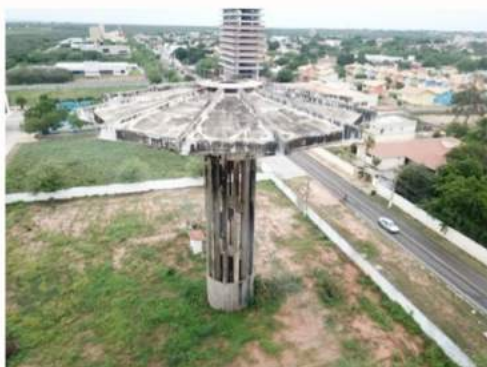
Figura 6: Perfil da caixa d'água
