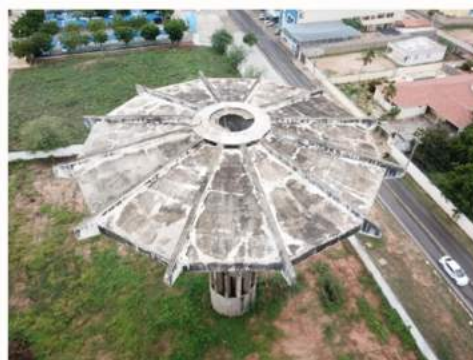
Figura 7: Vista superior da caixa d'água
