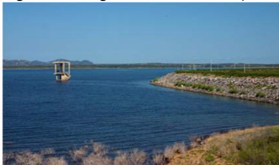
Figura 4: Barragem Armando R. Gonçalves
