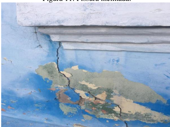
Figura 11: Fissura inclinada.
