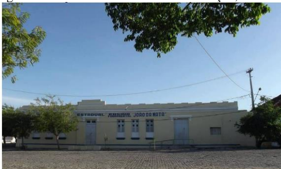
Figura 3: Escola antes da última restauração, em 2014.
