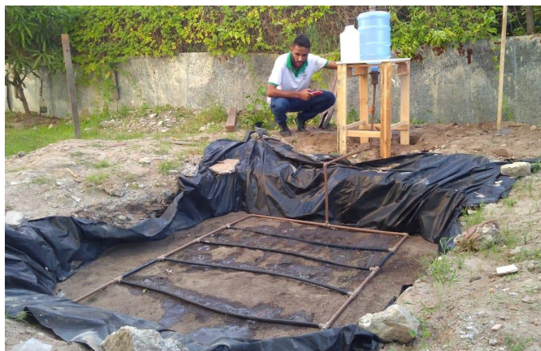
Figura 8 – Implantação do sistema e primeiro teste de vazão da água.
