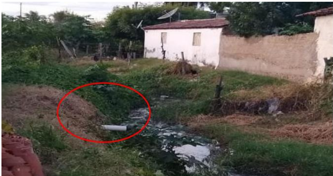
Figura 05 – Lançamento de águas residuais domiciliares no córrego de água pluvial
