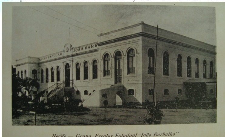
Figura 2: Grupo Escolar Estadual João Barbalho, Bairro da Boa Vista - Recife.
