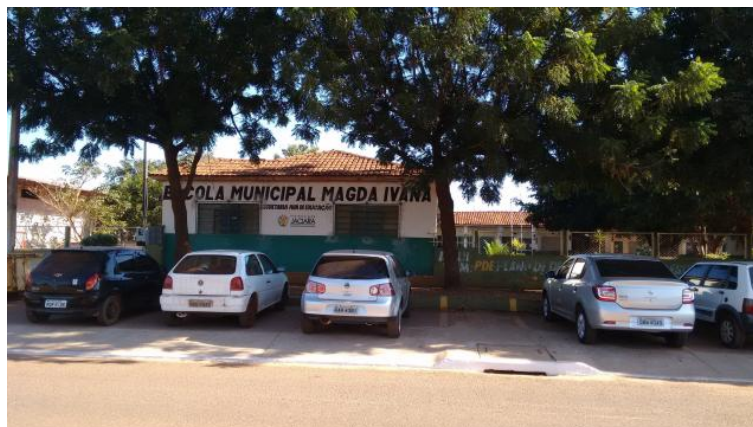
Figura 1 – Fachada da Escola Municipal Magda Ivana.
