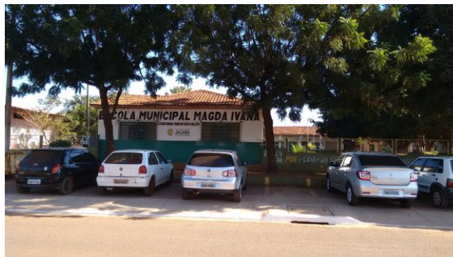
Figura 1 – Fachada da Escola Municipal Magda Ivana.
