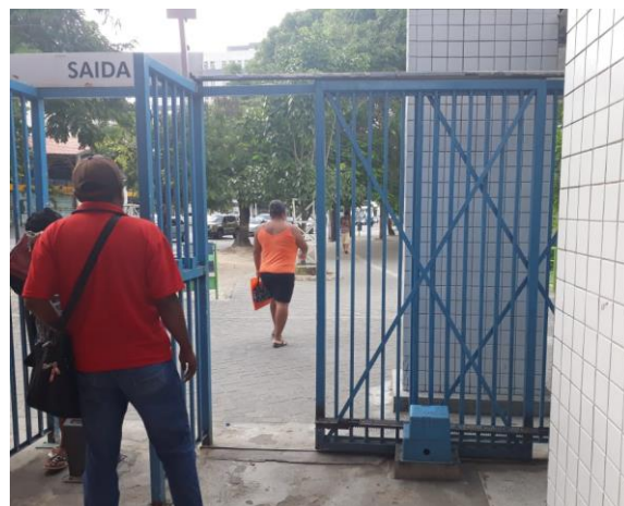
Figura 03: Acesso sem sinalização aberto.
