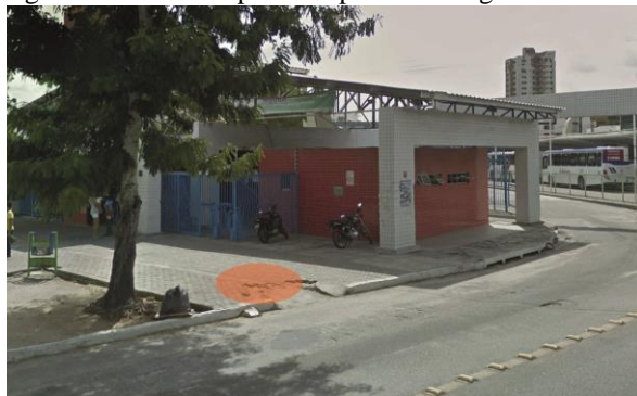
Figura 06: Piso tátil para rampa PNE antiga.
