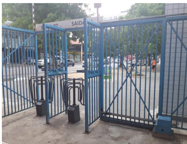
Figura 02: Acesso sem sinalização fechado.
