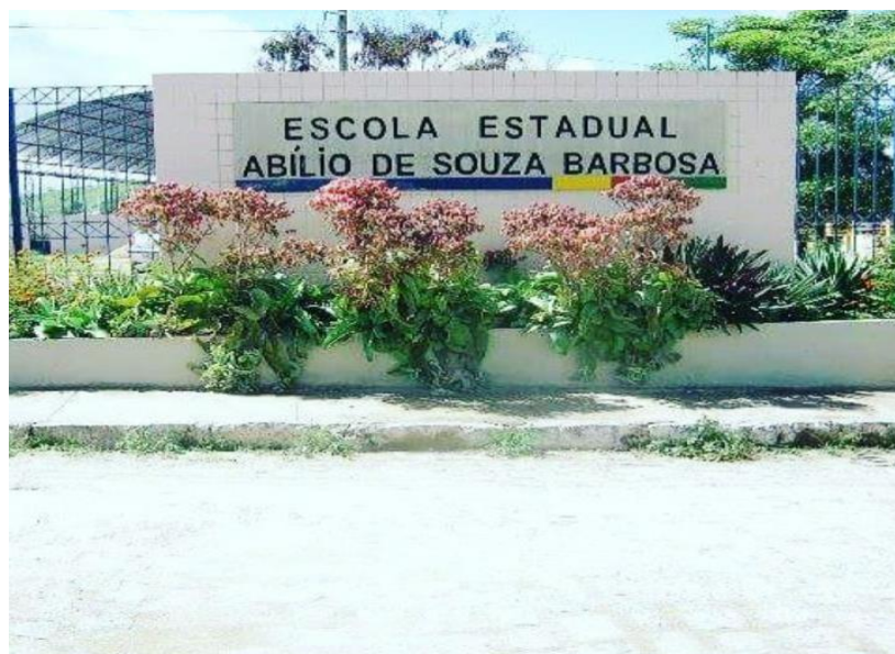
Figura-1: Vista frontal da escola.
