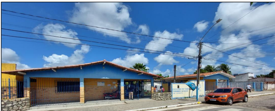
Figura 1 – Fachada da Escola Municipal Francisca Fernandes da Rocha “Xixica”.
