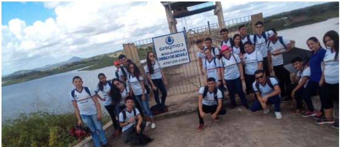
Figura 3: Barragem de Lagoa do Carro – PE.
