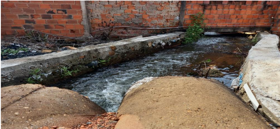
Figura 6: Canalização da Lagoa dos Muricis.
