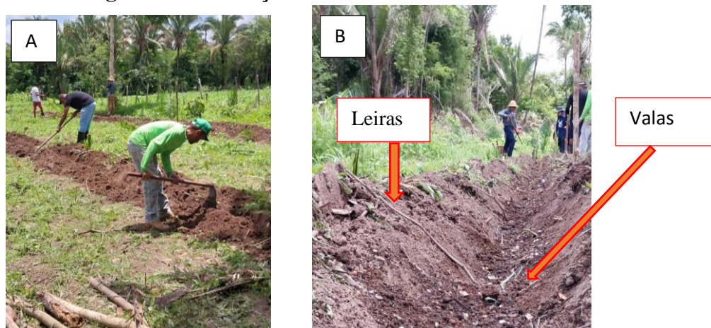
Figura 2: Construção das valas e leiras
