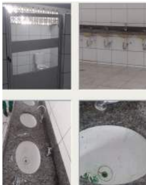
Figura 3 - Registros das áreas externas à sala de aula - banheiros
