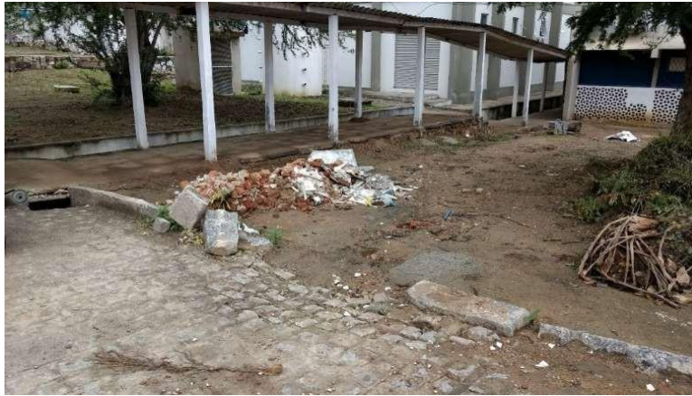
Figura 6 - Entulho e material orgânico ao lado do bloco CA/UFCG
