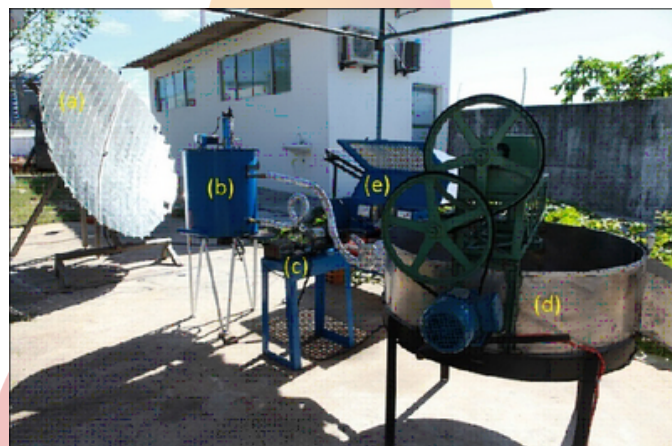
Figura 1. (a) Concentrador solar tipo Scheffler. (b) Forno absorvedor híbrido solar/gás. (c) Sistema de bombeamento. (d) Forno para torração da farinha. (e) Unidade de geração de energia de energia elétrica.
