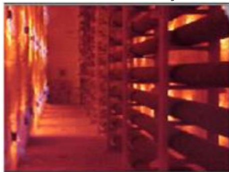
Figura 2 – Vista interna da seção radiante.
