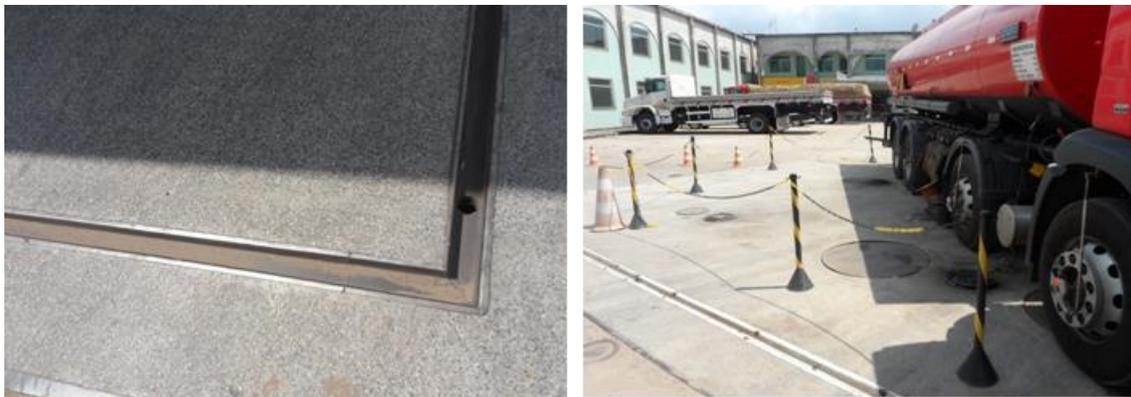
Figura 1: Canaletas e piso de alta resistência e Área de armazenamento e descarregamento.
