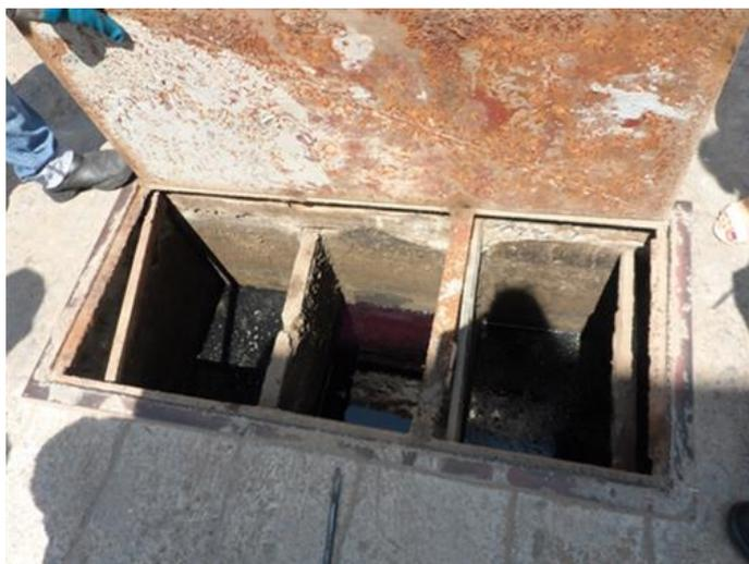
Figura 2: Caixa coletora Água/ Óleo.
