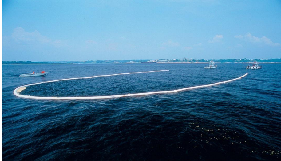
Figura 5: Barcos recolhedores realizando a concentração do óleo em um ponto específico.
