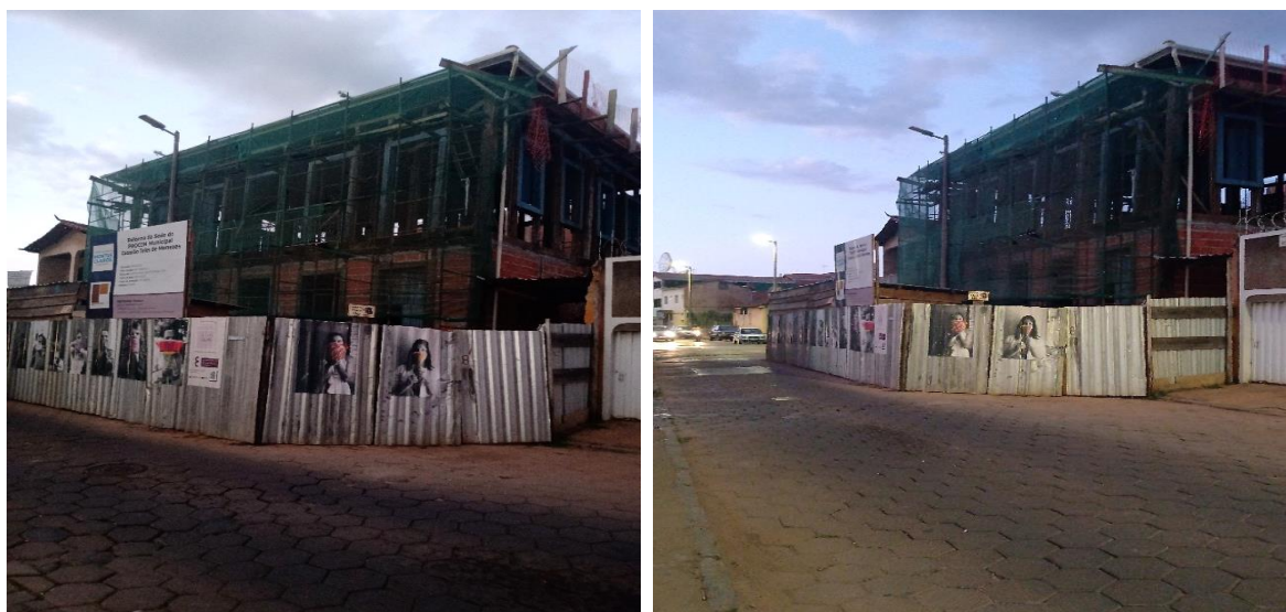
Figura 2: Tapume ocupando parte da rua e a calçada em frente ao Sobrado n° 93 que está em processo de restauração, Rua Justino Câmara Fonte: Acervo pessoal, 2021.
