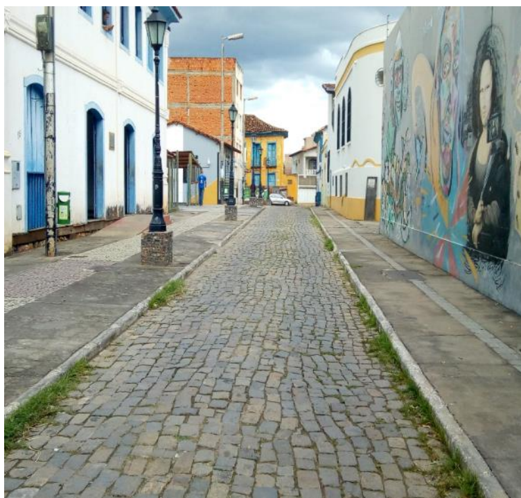
Figura 4: Calçadas com rampa e piso podotátil, Rua Coronel Celestino
