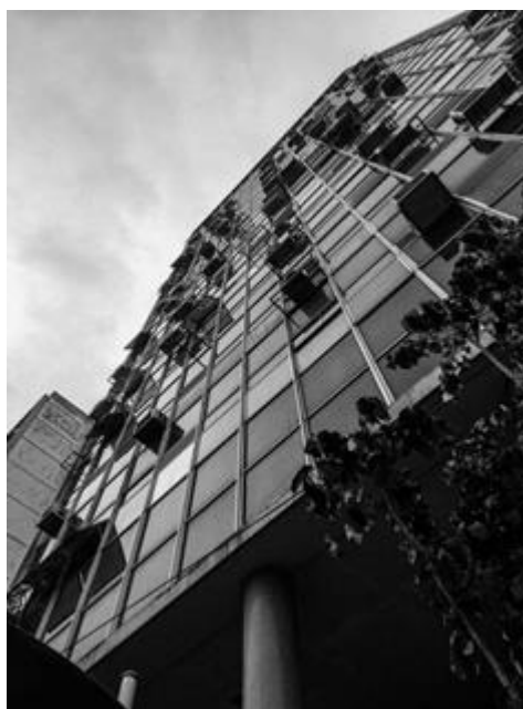
Figura 12: profundidade produzida pela angulação e pelas linhas do prédio. Fonte: arquivo próprio, 2019.
