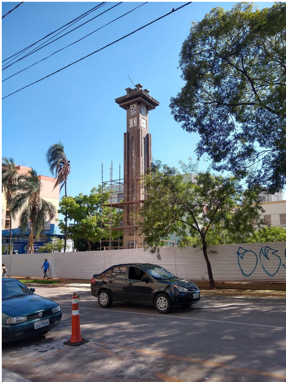
Figura 3. Foto Avenida Goiás, reforma do BRT Norte/Sul
