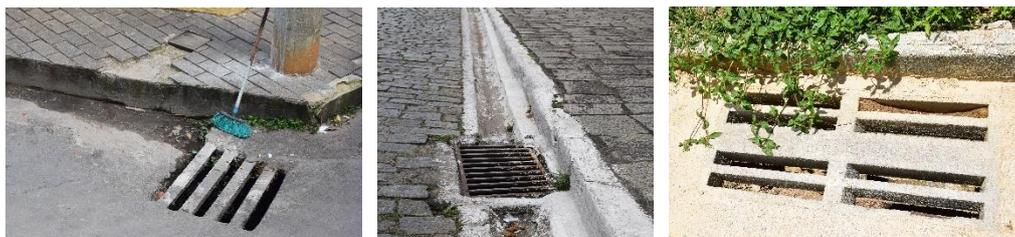
Figura 10: alguns dos tipos de bueiros existentes nas áreas de estudo.
