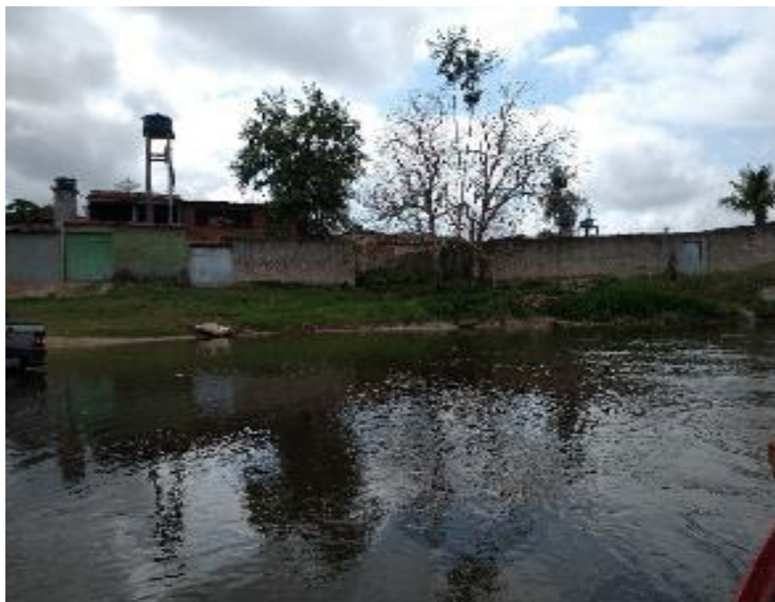
Figura 03 – Muros residenciais e comerciais no leito maior (margem direita) do rio Jipuíba, no bairro Centro
