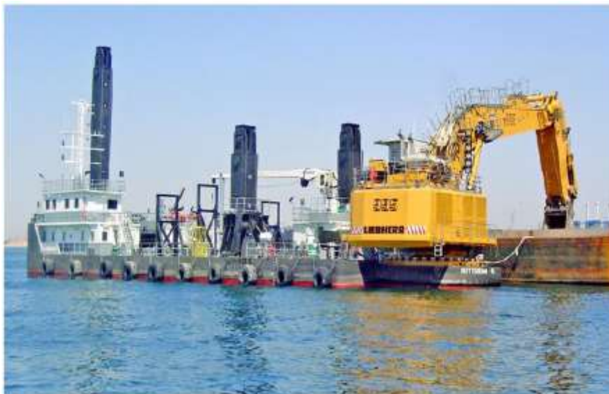
Figura 2 - Dragagem realizada no Porto de Jaraguá/AL. Fonte: Administração do Porto de Maceió, 2019.
