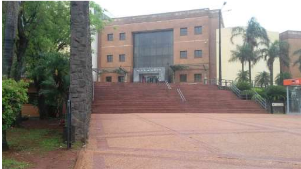
Fotografia 7. Prédio do Palácio da Justiça em Pedro Juan Caballero, 2019.
