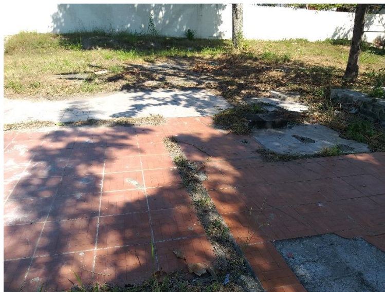
Foto 1 – Piso em ruínas – Museu das Remoções. Foto da autora (2019).
