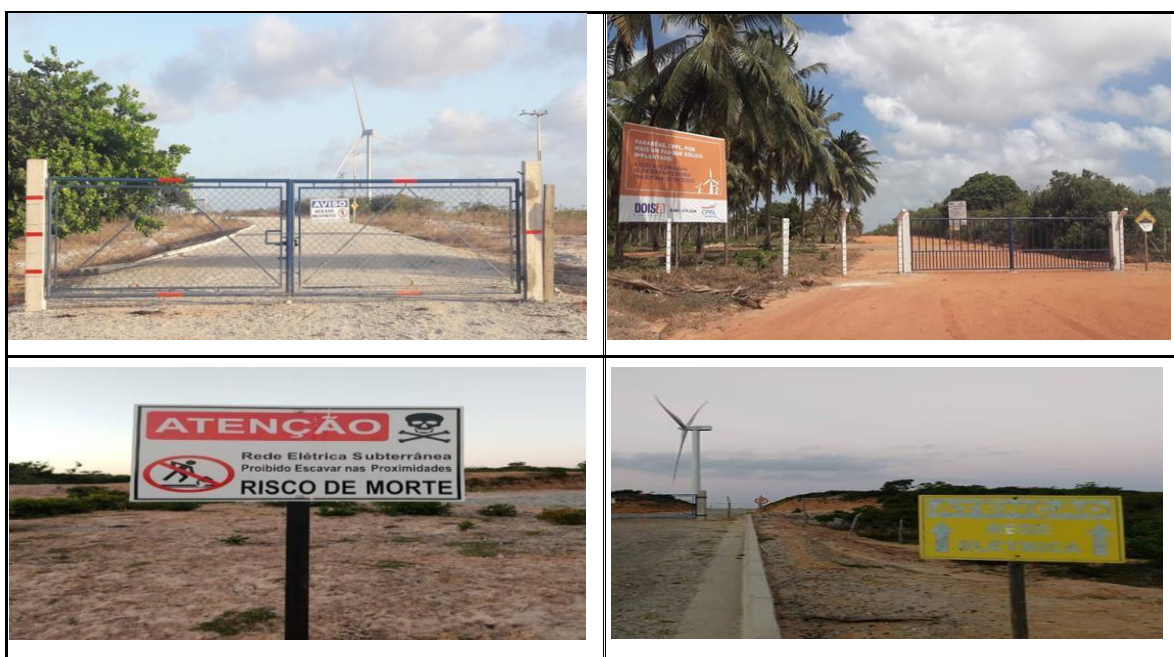
Figura 5: Danos socioambientais causados nas fases de instalação e operação dos empreendimentos eólicos como: vias de acesso ao parque com uso restrito; placas de risco de morte devido à presença de rede elétrica subterrânea; cercamento de terras inviabilizando a pecuária extensiva.
